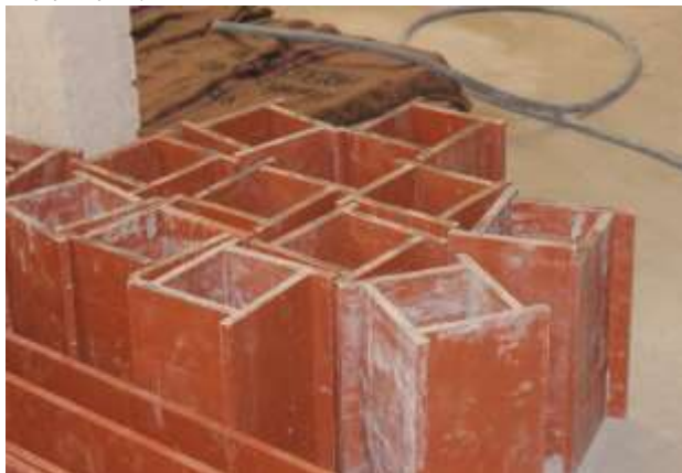
Hình 4: Công tác gia công khuôn mẫu
