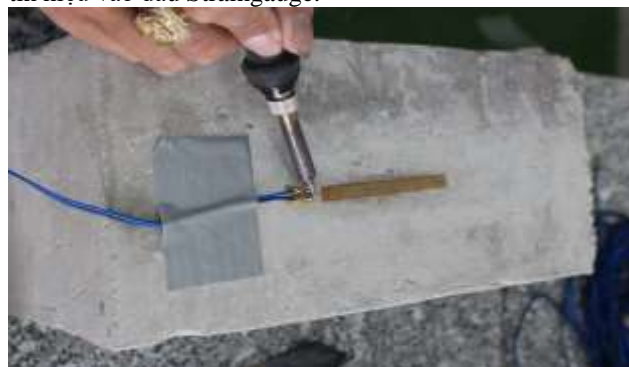
Hình 7: Lắp đặt các cảm biến đo biến dạng (Straingauge) trên cột bê tông
