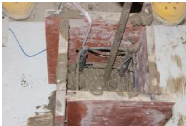
Hình 5: Công tác đúc mẫu cột bê tông hình trụ vuông
